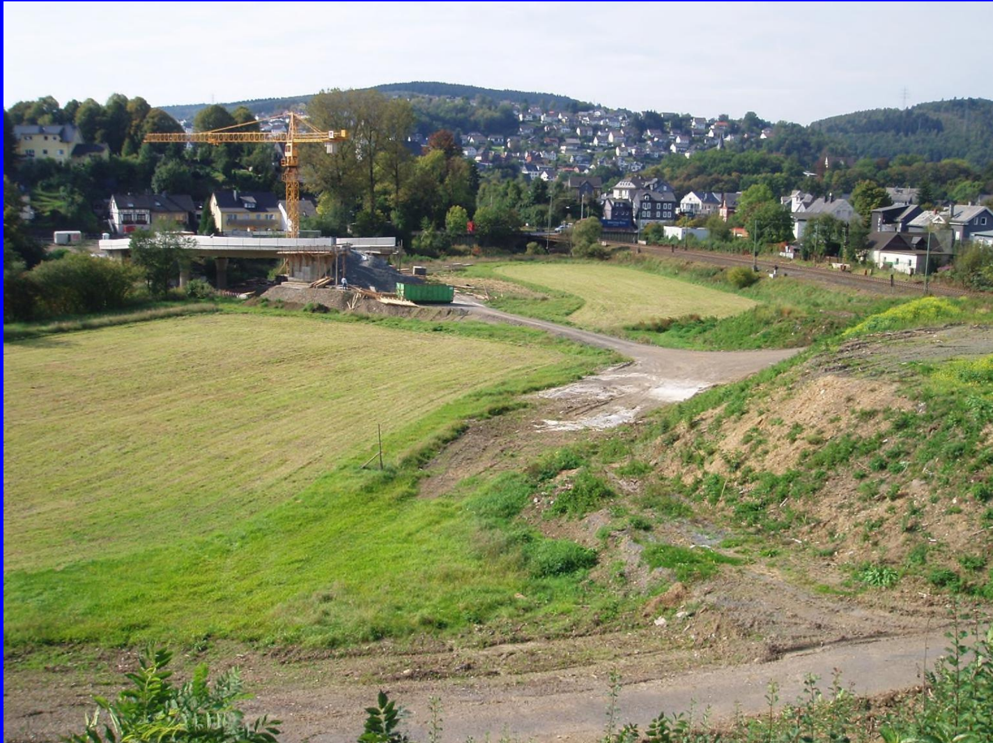
Neubau Hüttentalstraße Damm D4
