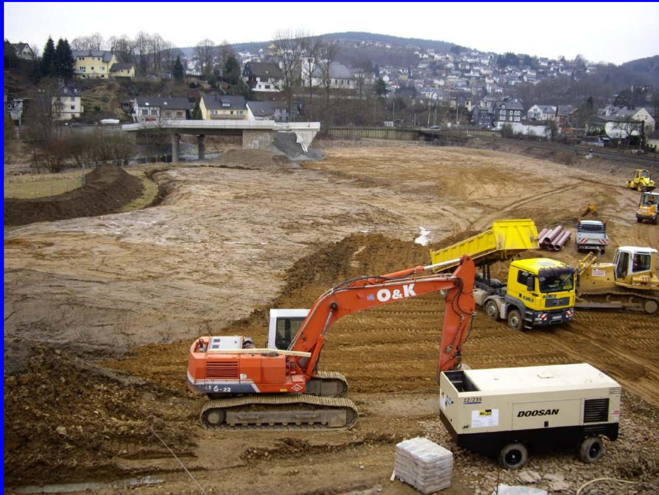
Neubau Hüttentalstraße Damm D4
