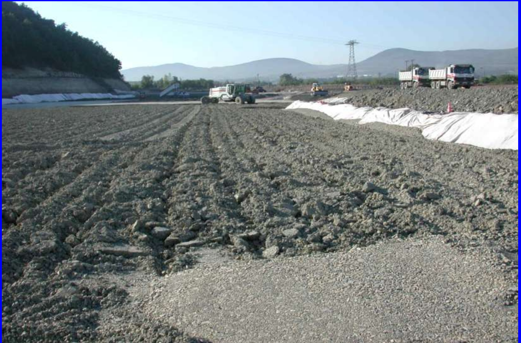
Großbaustelle mit Flächenrecycling / Rudolstadt-Schwarza 2. Symposium Umweltgeotechnik der DGGT E.V. TU Bergakademie Freiberg / Sachsen
